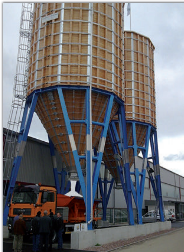
Streufahrzeugbeladung ab Silo, Bsp. Münchwilen AG
